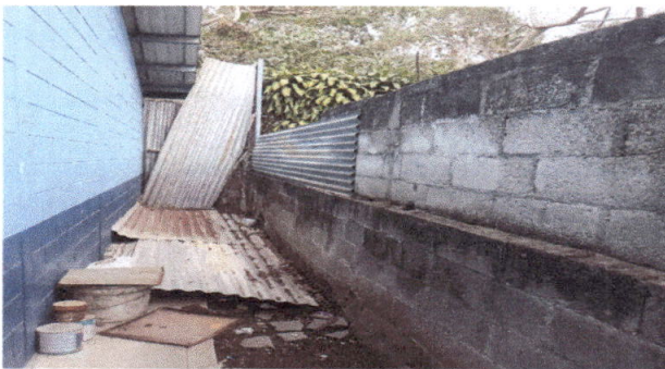
Foto 5: Reparación de muro perimetral de block
