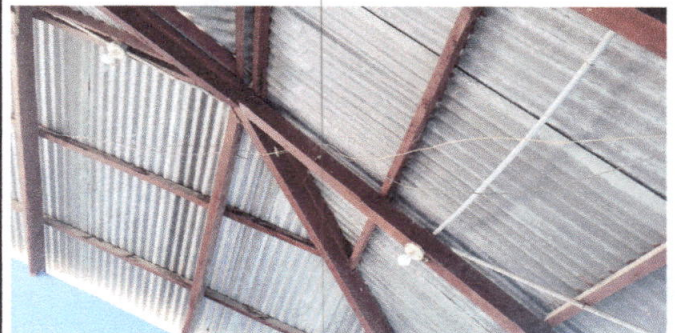
Foto 4: Reparación de sistema eléctrico
