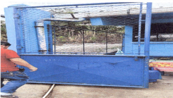
Fotografía 11: sustitución de portón
