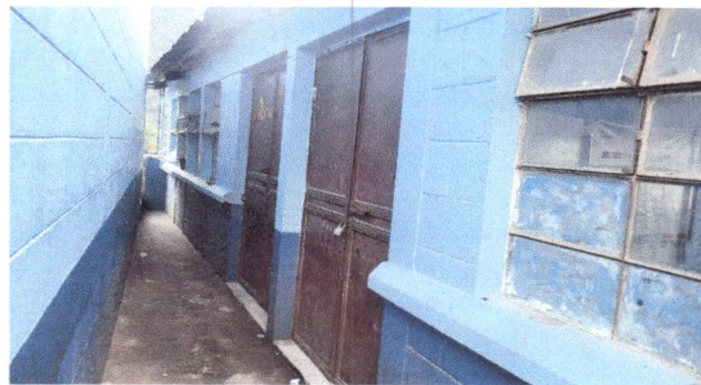
Fotografía 10: sustitución de puertas
