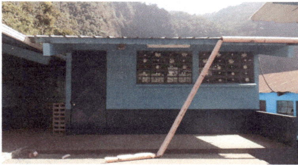
Foto 3: Sustrucción de canales de agua
