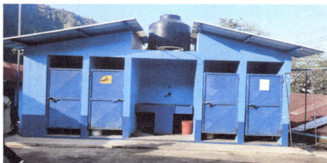
Fotografía 7: Reparación de puertas
