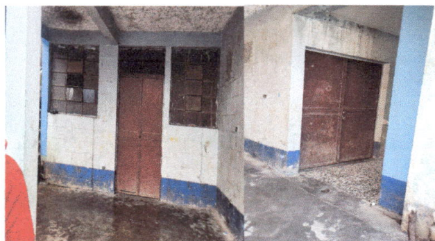
Fotografía 9: sustitución de puertas
