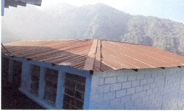
Foto 1: Sustrucción de cubierta de lámina
